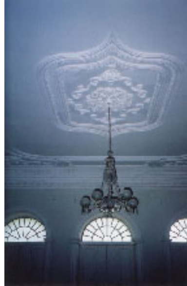
Fig. 86 – SOLAR RODRIGUES MENDES, RECIFE – PE, FORRO EM ESTUQUE .
