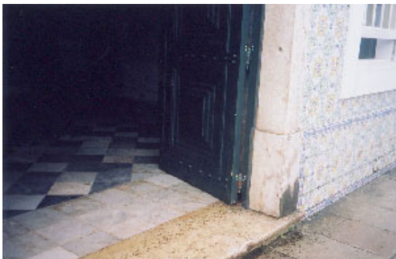
Fig. 97 – CASARÃO DA MADALENA, RECIFE – PE, SOLEIRA.
