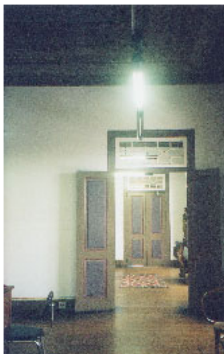
Fig. 98 – CASARÃO DA MADALENA, RECIFE – PE, PORTAS INTERNAS.
