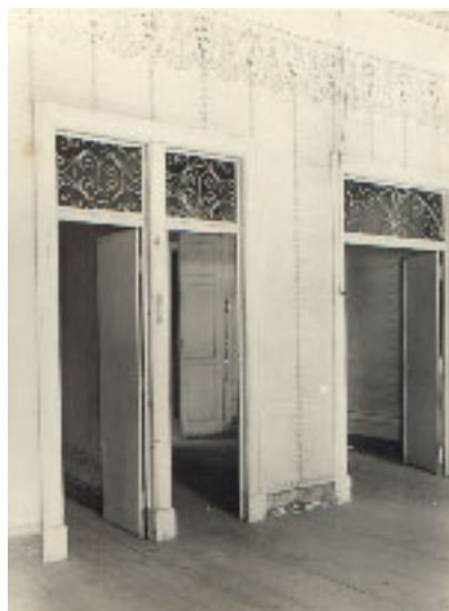
Fig. 89 – SOLAR RODRIGUES MENDES, RECIFE – PE, SALÃO DE HONRA. Observamos neste salão o piso em soalho que percorre todo o primeiro pavimento, as portas internas com bandeiras em ferro trabalhado, assim como a barra de pinturas na parede. . (Crédito da ilustração: cópia de fotos do Arquivo do IPHAN, datadas de 1969, no. de registro 34.01(35)/255.56/ 9245/86 a 9247/86).
