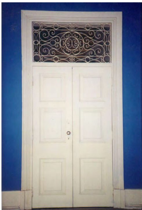
Fig. 126 – CASA 1893, AV. 17 DE AGOSTO, RECIFE – PE, PORTA INTERNA. Porta interna da residência, com três almofadas, típica de finais do século XIX, e bandeira da porta em ferro ornamentado. (Crédito da Ilustração: Foto da Autora, datada de 2001).
