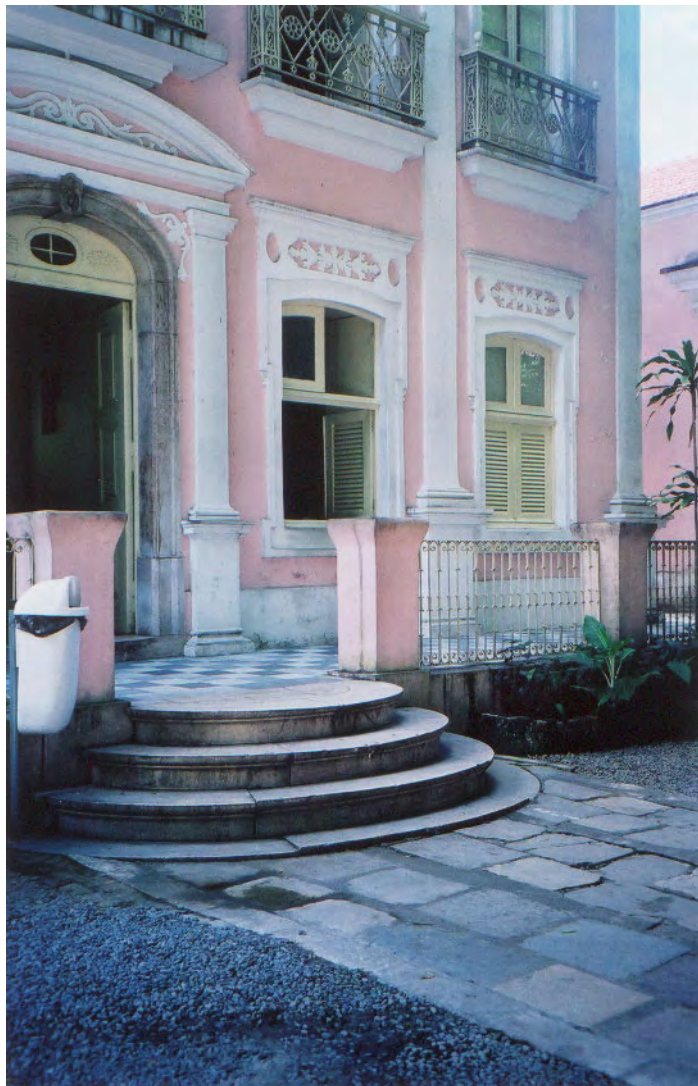
Fig. 115 – CASA 150, RUA BENFICA, RECIFE – PE, TERRAÇO DE ENTRADA.
