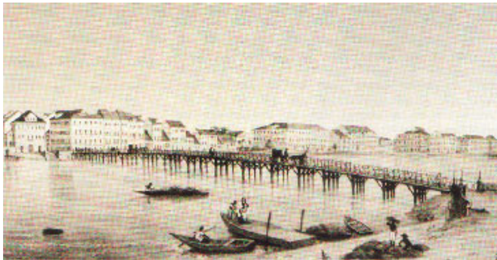
Fig. 21 – CASARIO DA RUA DA AURORA, RECIFE – PE.
