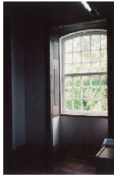
Fig. 100 – CASARÃO DA MADALENA, RECIFE – PE, JANELAS. Janelas de guilhotina com vidraças, que aparecem nas nossas residências a partir do século XIX (Crédito da Ilustração: Foto da Autora, datada de 2002).
