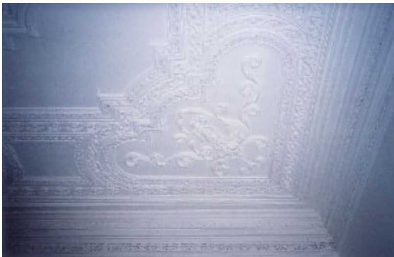
Fig. 84 – SOLAR RODRIGUES MENDES, RECIFE – PE, FORRO EM ESTUQUE.
