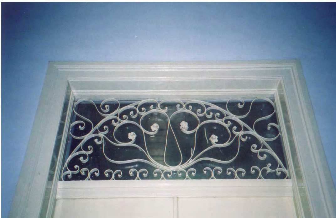
Fig.119–CASA 150,RUA BENFICA, RECIFE – PE, BANDEIRA DAS ESQUADRIAS INTERNAS.
