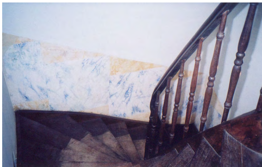
Fig. 106 – CASA 813, RUA OLIVEIRA LIMA, RECIFE – PE, ESCADA.
