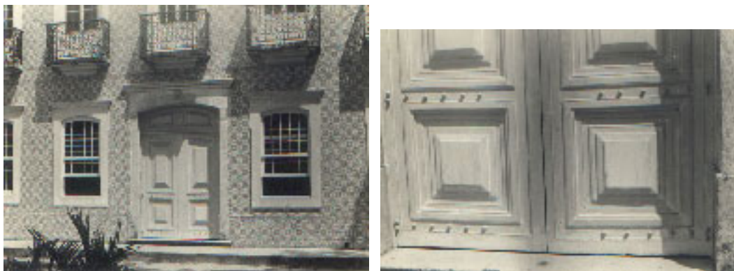
Fig. 101, 102 - CASARÃO DA MADALENA, RECIFE – PE, PORTA PRINCIPAL. Aspectos da porta principal do casarão com grandes almofadas de madeira. (Crédito da ilustração: cópia de foto dos arquivos do IPHAN, no. de registro 34.01(7) / 230 .53 s/d / 8106/86 a 8111/86).
