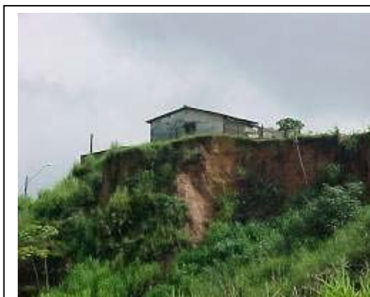
Figura 1.9 – Recife: Área de risco por erosão em morro do Ibura
