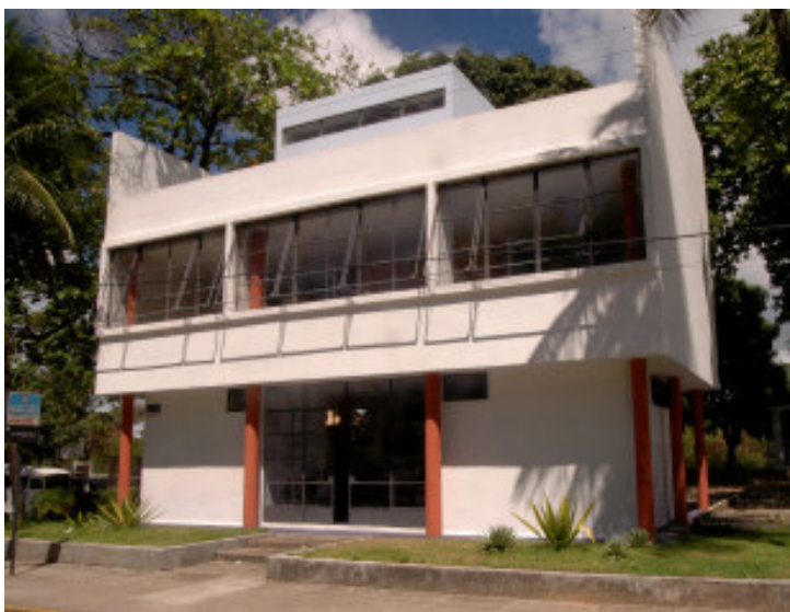
Antigo Pavilhão de Verificação de Óbitos, hoje sede local do Instituto de Arquitetos do Brasil – IAB , no bairro do Derby: projeto de Luiz Nunes, sob a influência de Le Corbusier, na década de 30.
