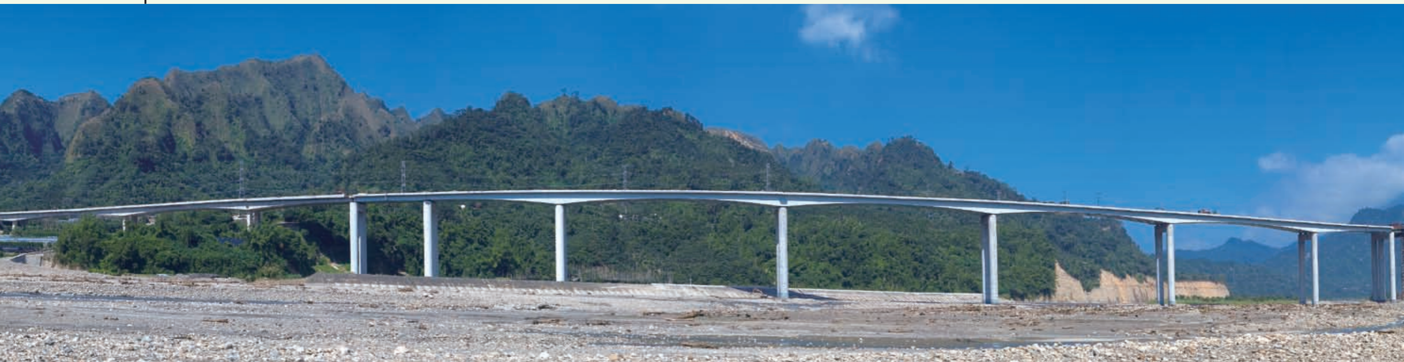
圖12 國姓高架橋 (齊柏林攝)
