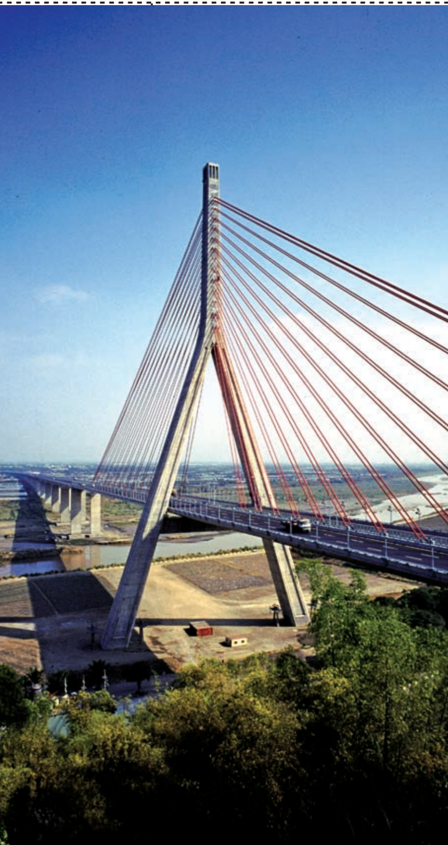
圖4 高屏溪斜張橋 (齊柏林攝)
