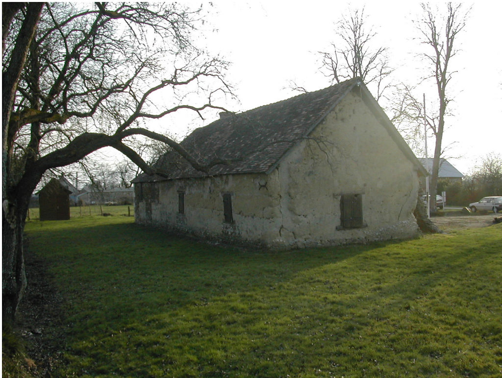
Photographie 2 : La même ferme, vue de l'arrière (mur d'origine en bauge ou pisé).
