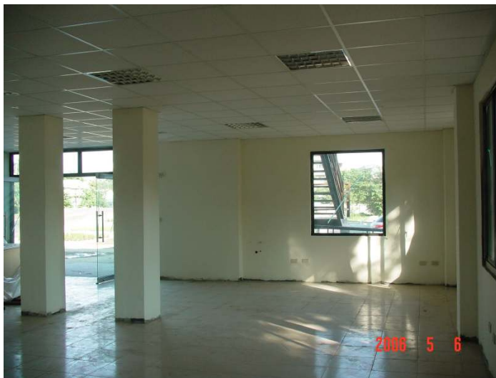
圖 3-10 眷村文化館 1F 室內空間整修現況
