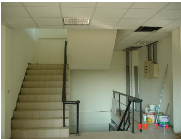
圖 3-11 眷村文化館 1F 室內空間整修現況
