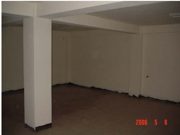
圖 3-19 眷村文化館地下一樓整修現況
