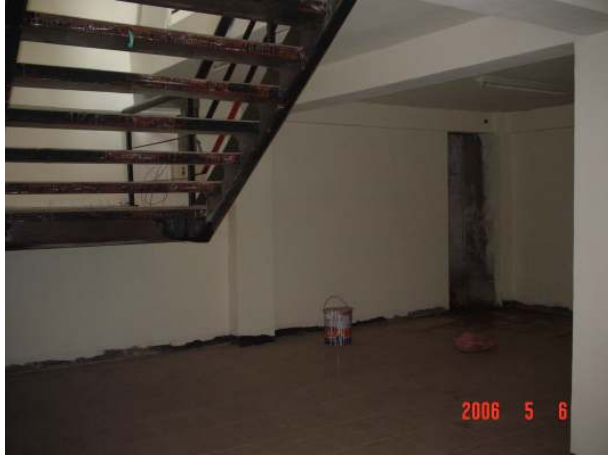
圖 3-18 眷村文化館地下一樓整修現況
